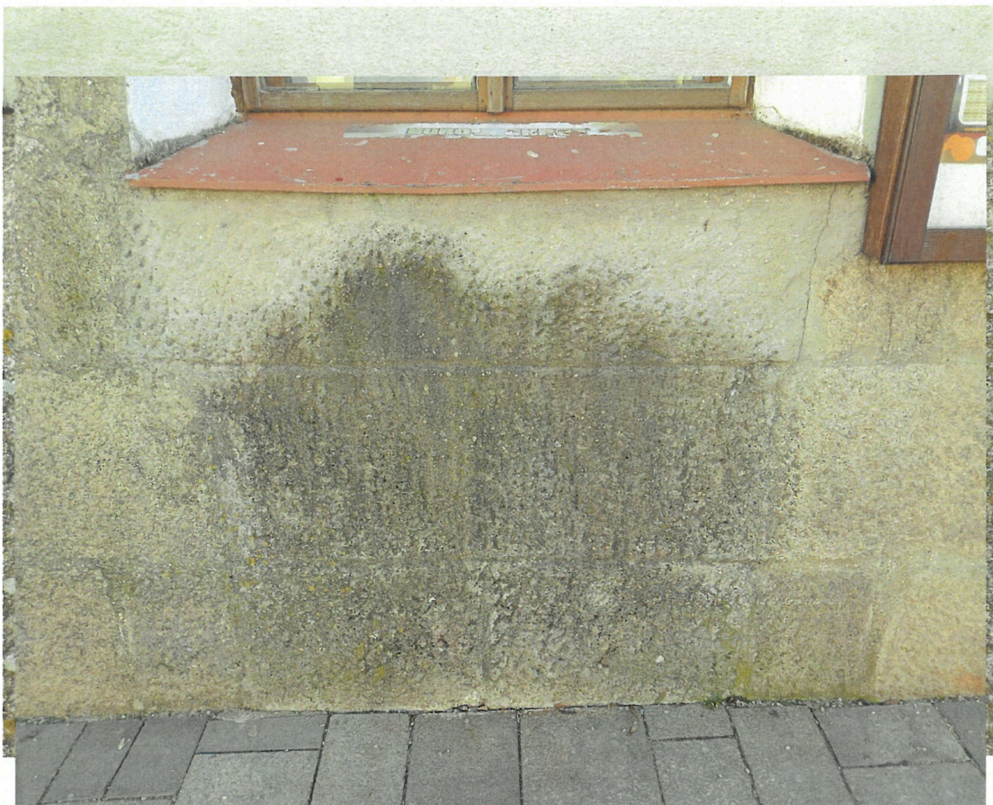
Kamenný blok s vytesaným nápisem a část plochy pod okenním parapetem doplněná v umělém kameni.
