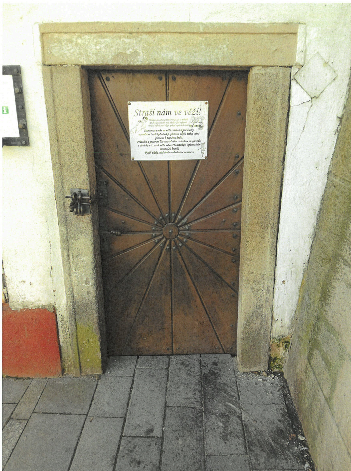
Boční vstup věže- malý kamenný vstup s rovným překladem.
