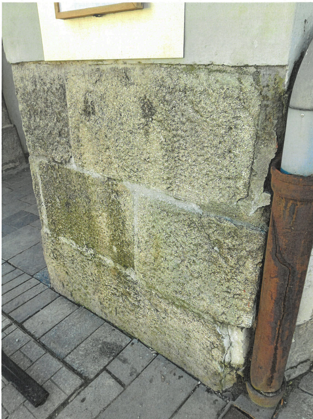
Kamenný sokl stavby. Typ znečištění a pohled na různé cementové vysprávkky.
