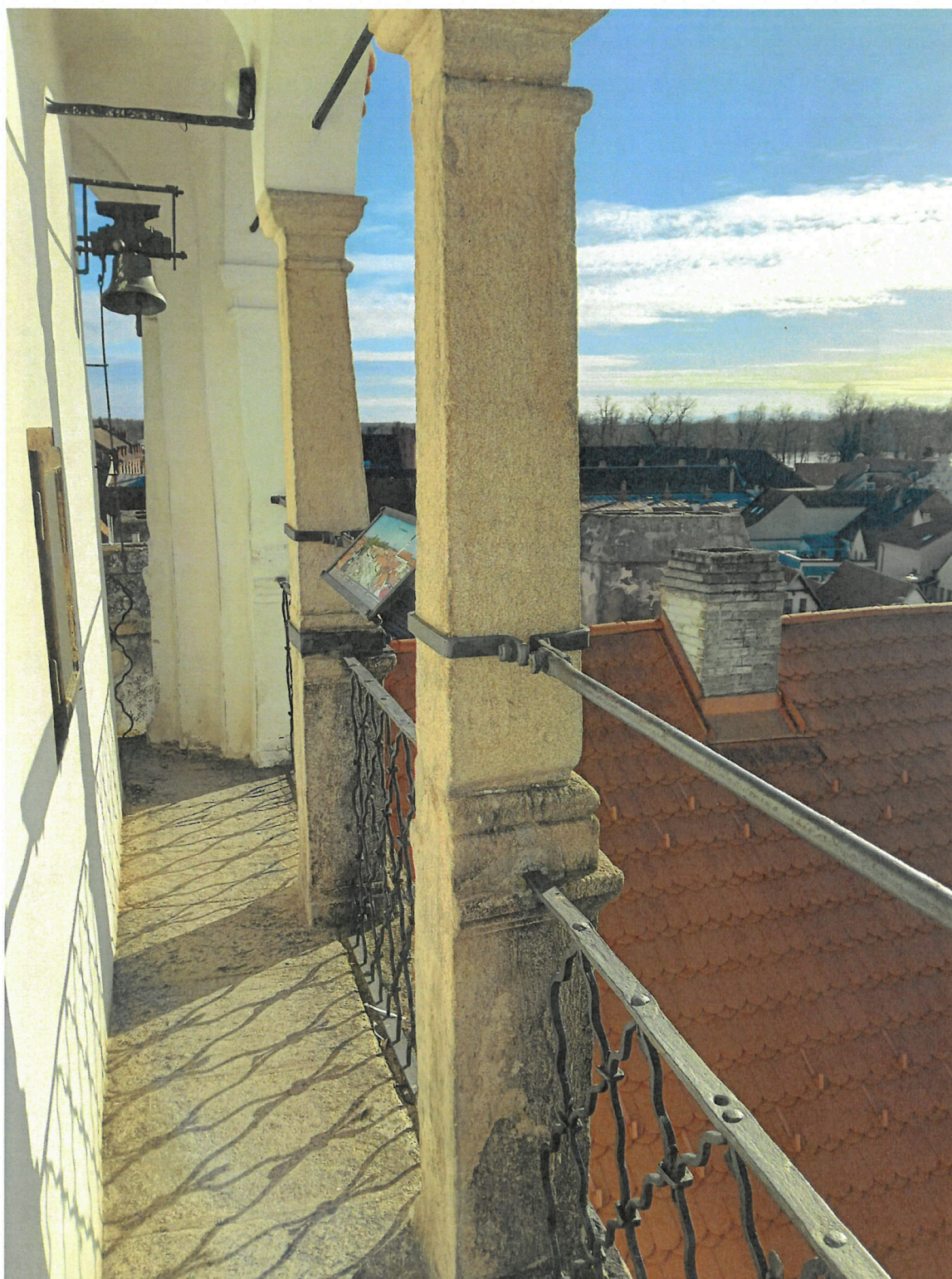
Pohled na sloupy ochozu věže a kamennou zádlažbu. Kované zábradlí je kotveno do kamenného materiálu a zacementováno.
