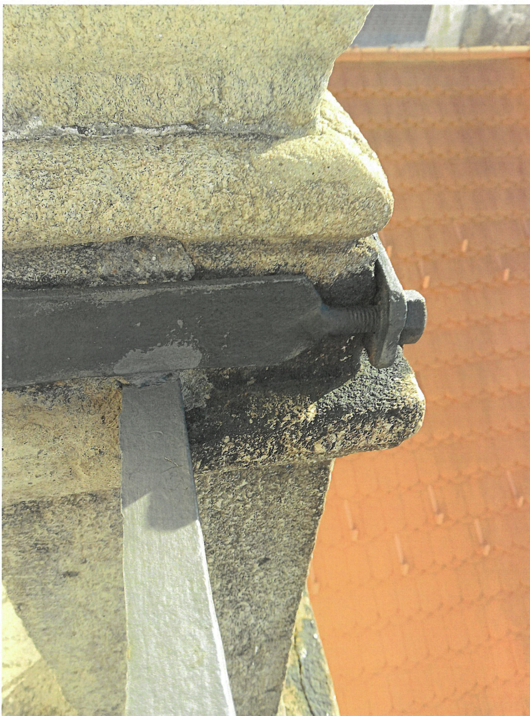
Pohled detailní na černou mastnou krustu- jeden z typů znečištění.
